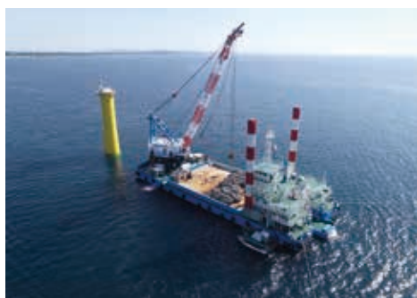
第三若美号による秋田港洋上風力洗掘防止工
